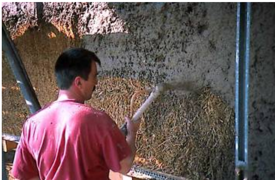
Figuur 10.26 Machinaal aanbrengen van pleister
