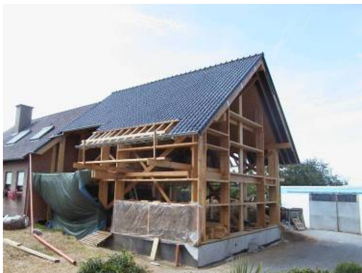
Figuur 8.3 bescherming van stobalen door middel van plastic
