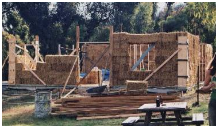
Figuur 10.9 Opbouw van Nebraskastijl
