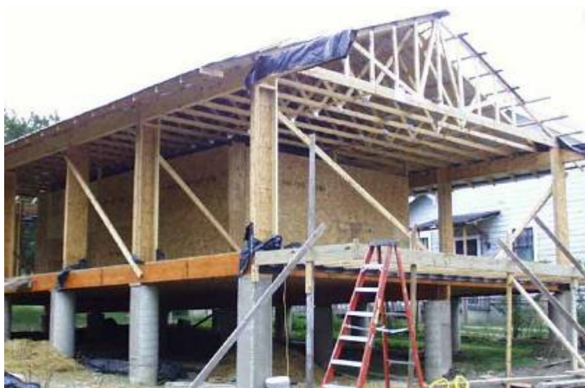
Figuur 10.7 Paalfundering
