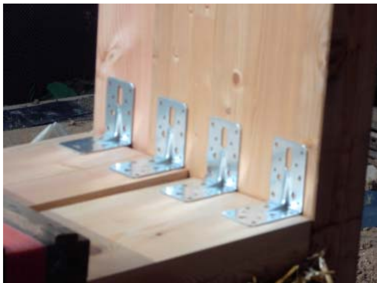
Figuur 10.18 Bevestiging dwarsbalk door stalen voetjes
