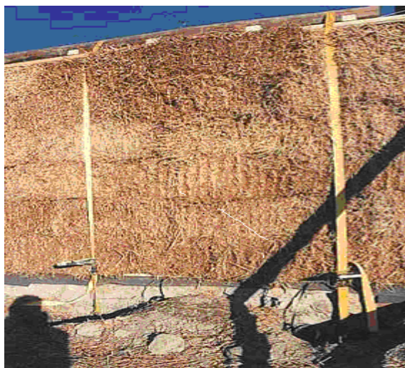
Figuur 10.11 Compactering door middel van spanbanden
