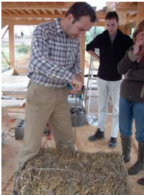
Figuur 4.2 Strobaal wordt opnieuw ingebonden, een nieuw touw wordt door middel van een stang door de strobaal gestoken
