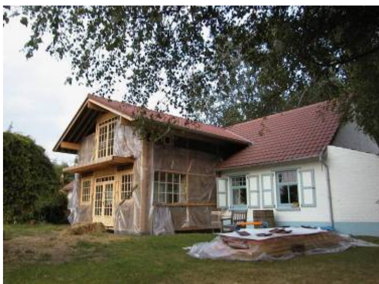
Figuur 8.4 plasticen bescherming tegen vocht
