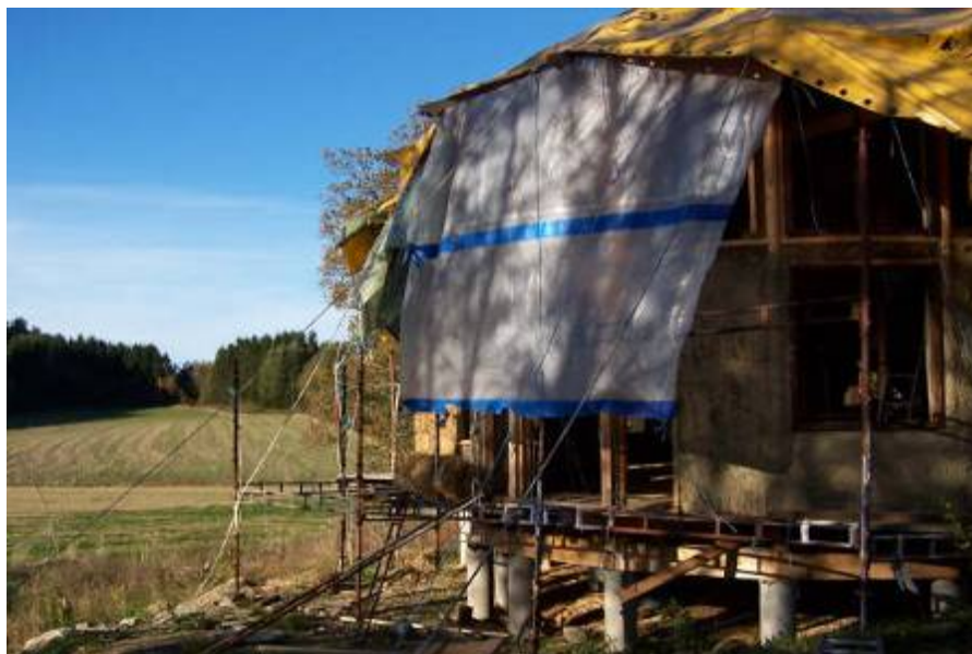
Figuur 10.6 Paalfundering
