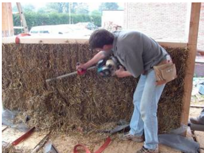
Figuur 10.22 Gladscheren van de strobalewand
