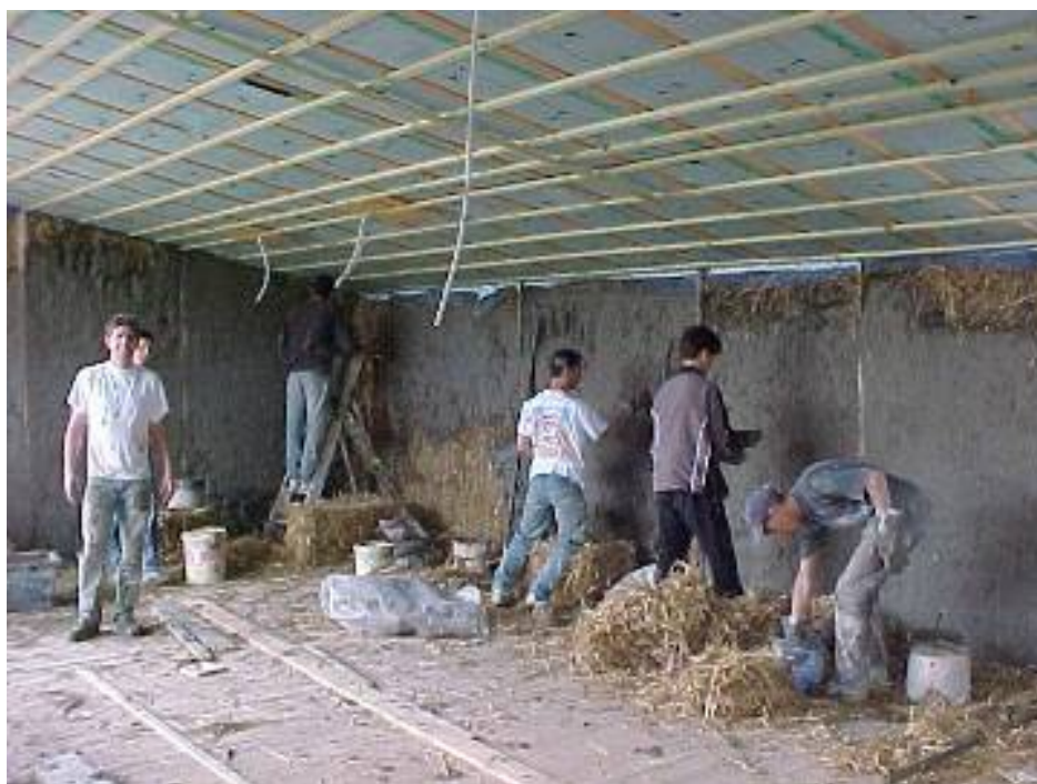
Figuur 10.27 Handmatig bepleisteren dmv plakspaan
