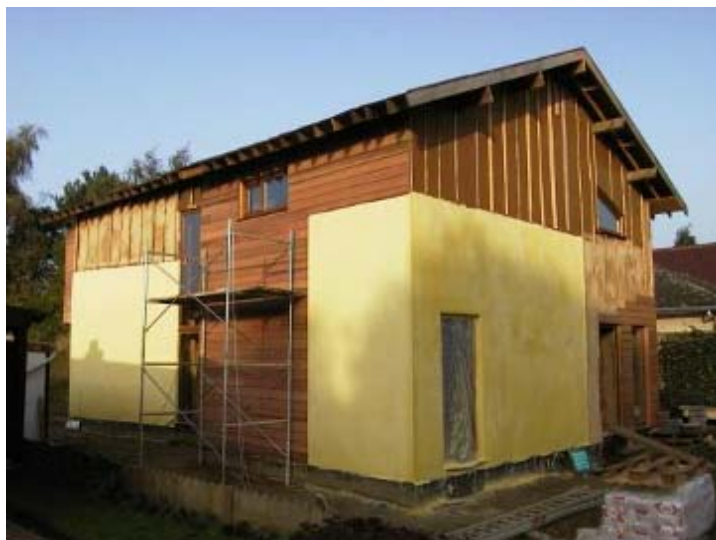
Figuur 10.24 Strakke kalkpleister
