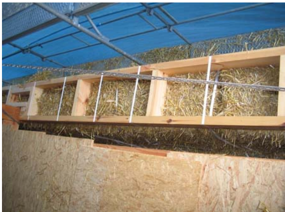
Figuur 10.12 Horizontale balk bovenop strobalenwand om deze gelijkmatig te kunnen samenspannen
