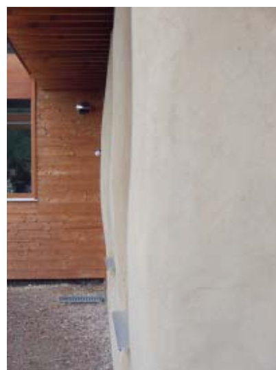
Figuur 10.25 Gewelfde leempleister
