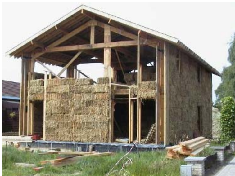
Figuur 10.16 Balloonbouwconstructie
