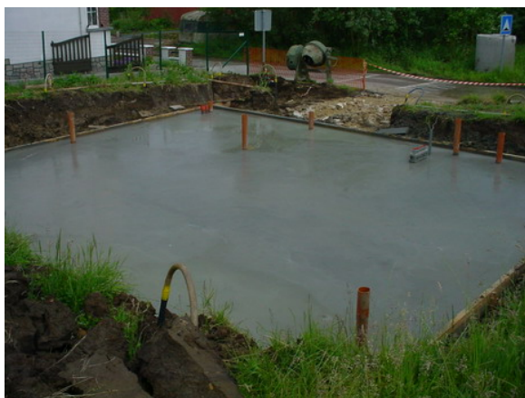
Figuur 11.1 Algemene funderingsplaat
