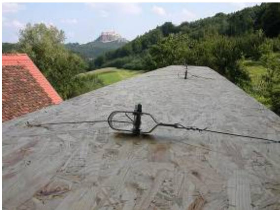
Figuur 10.13 compacteringsmechanisme
