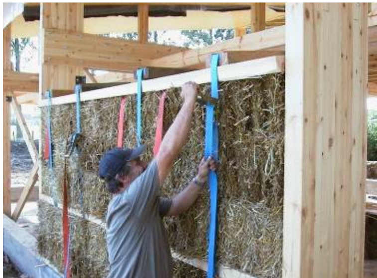
Figuur 10.17 Samenpersen van de strobalenwand
