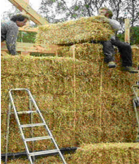
Figuur 10.14 Houtstaanders met stro als gevelvulling
