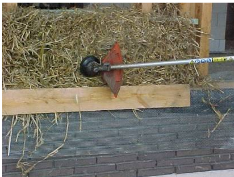
Figuur 10.23 Effenen van strobale dmv van bosmaaier
