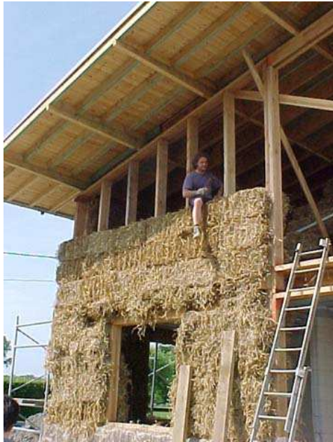
foto Henk Van Aelst Tijdens de bouw van Henks eigen woning. De strobale worden tussen de houtenskelet gestapeld.
