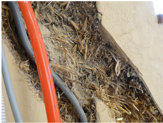
foto Hilke Andries De leidingen op de bovenverdieping liggen al klaar om ze in de toekomst aan te sluiten op de zonnepanelen.
